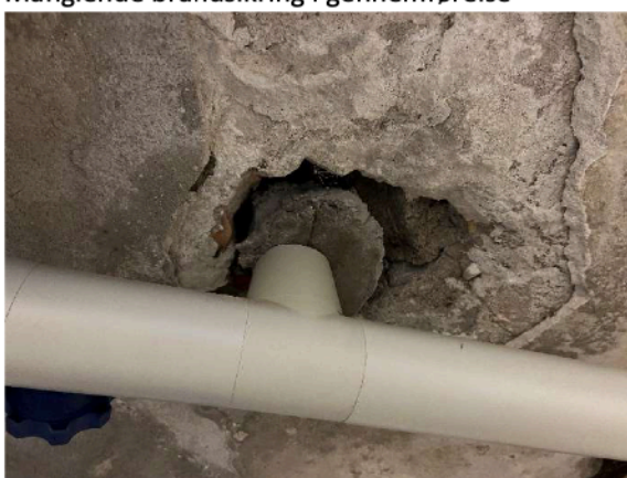
Manglende brandssikring
