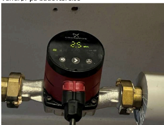
Cirkulationspumpe
